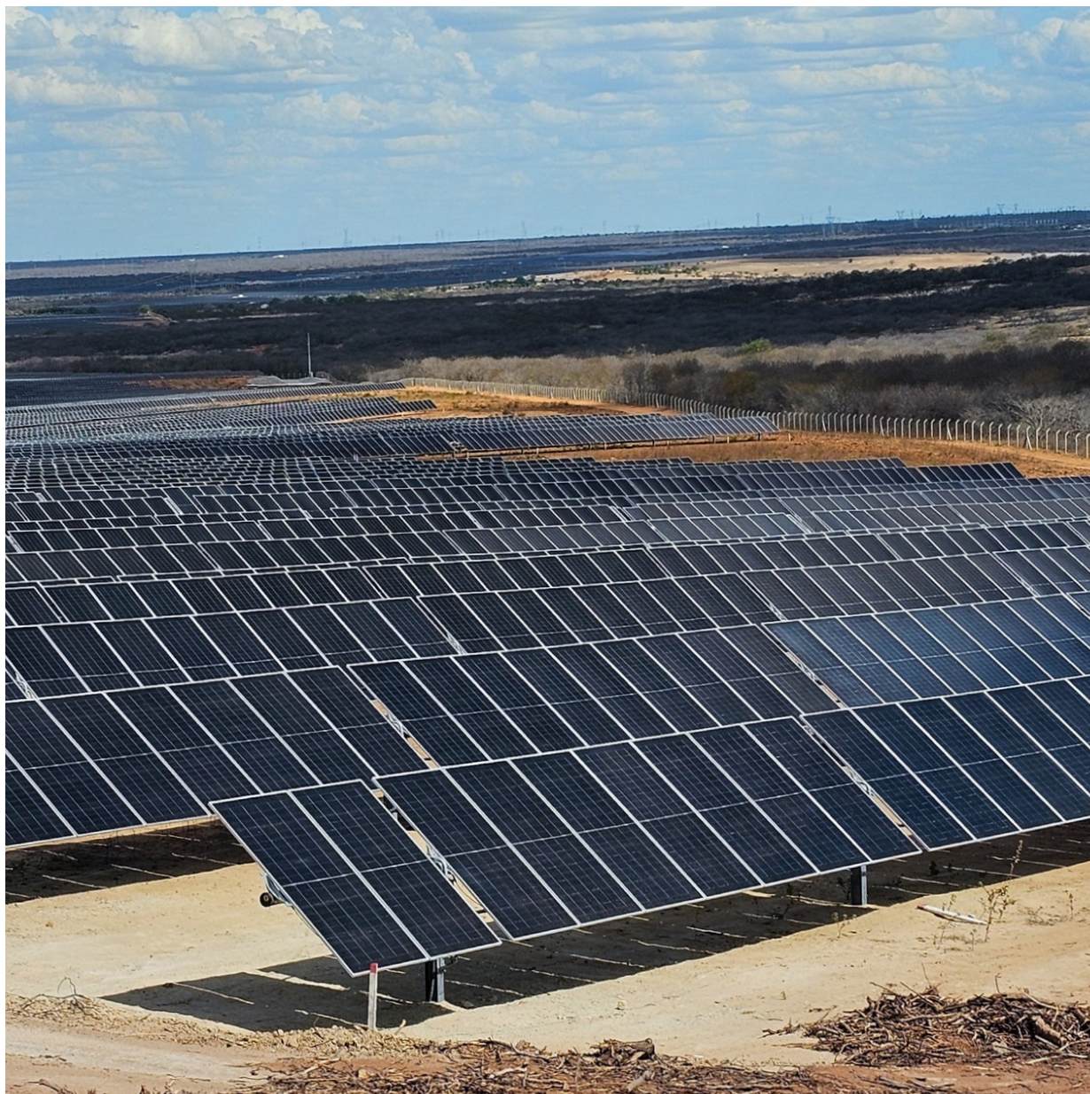
Figura 7 Conjunto fotovoltaico Assú Sol Por Jocelim Costa
